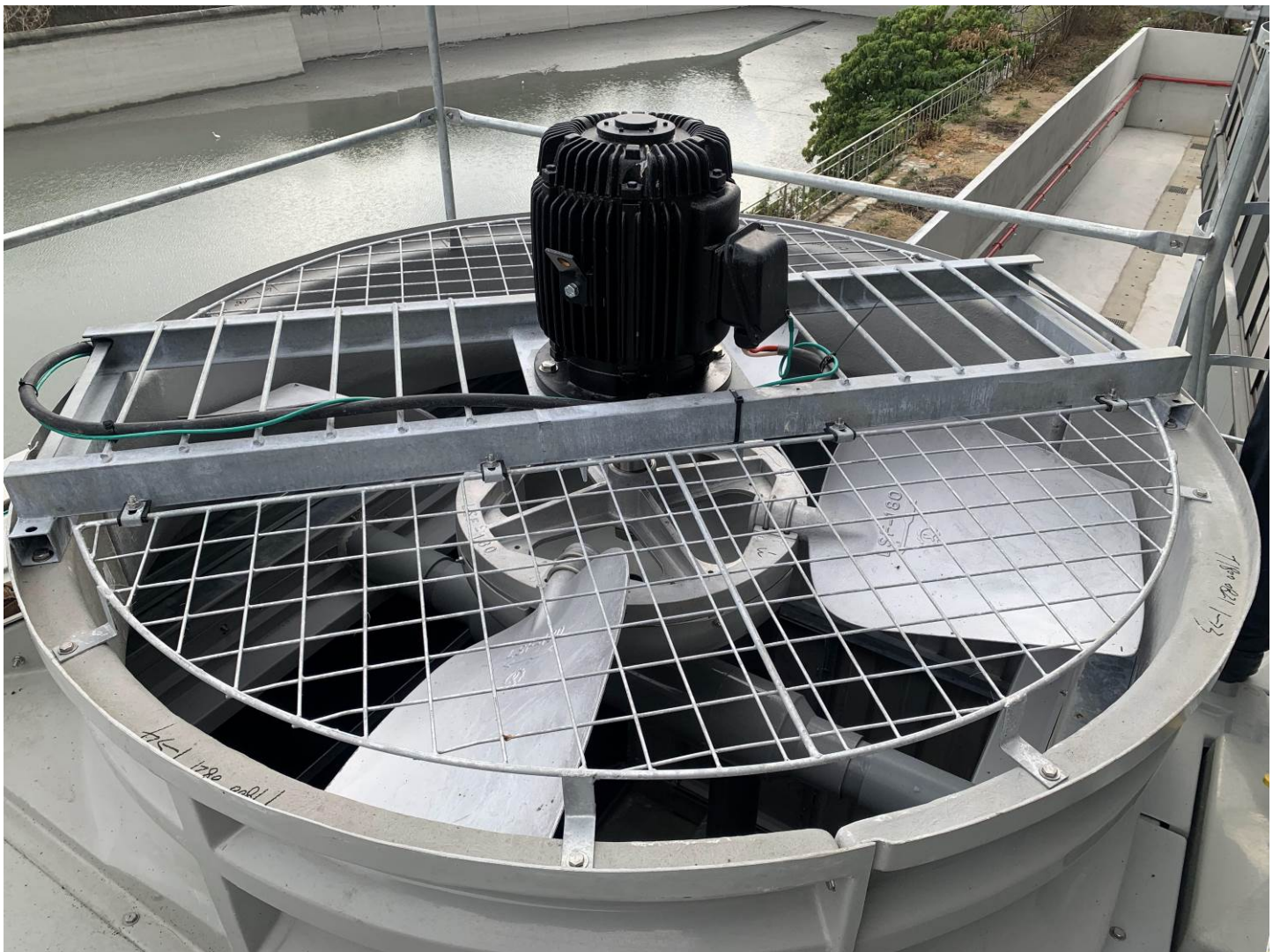
永磁直驅馬達與風車結合圖例
